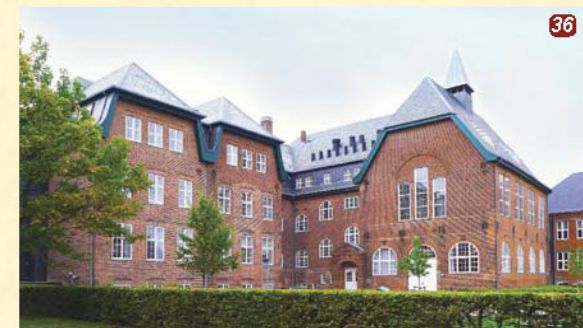
Tønder Gymnasium, Astronom Hansensgade 9
