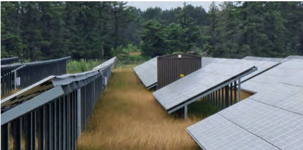
Figur 4-4 Eksempel på fordelingstransformer.
