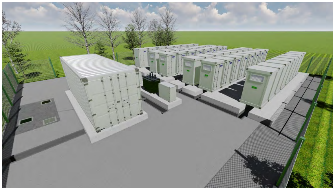
Figur 4-7 Eksempel på BESS anlæg på 20 MWh. Kilde: GreenGo Energy.
