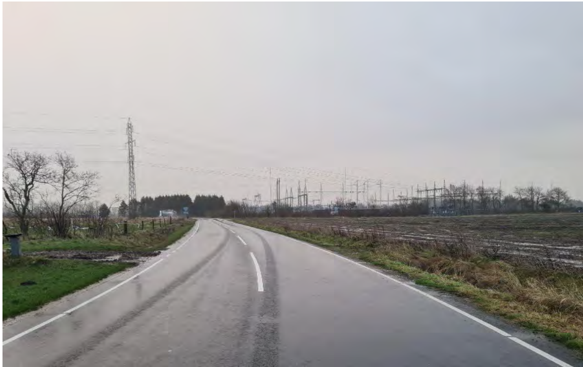
Kilde: LandSyd, december 2023. Transformatorstation på Galgemark i retning vest mod øst.
