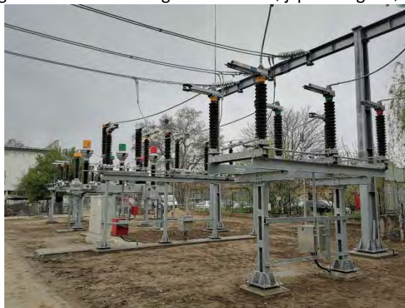
Figur 4-6 Eksempel på 150 kV fritstående system tv og kompakt system th.
