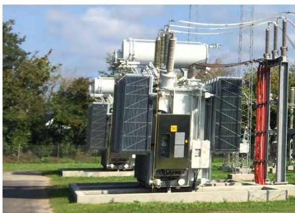
Figur 4-5 Eksempel på 150 kV transformatorstation tv og lynafledningsmaster th.
