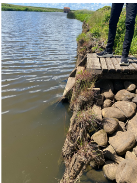
Figur 2. Eksempel på en kano trappebro ved Ballum Sluse, som følger brinkanlægget. Kanobroen i projektet vil ligne denne bro.
