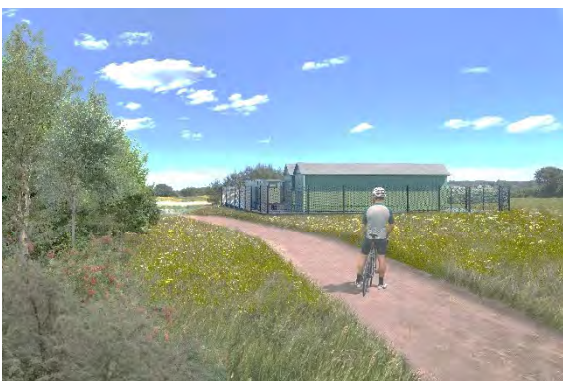
Figur 2-9 Eksempel på 20 MWh BESS anlæg.
