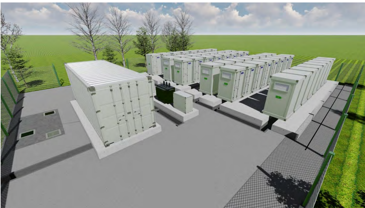
Figur 2-8 Eksempel på BESS anlæg på 20 MWh. Kilde: GreenGo Energy
