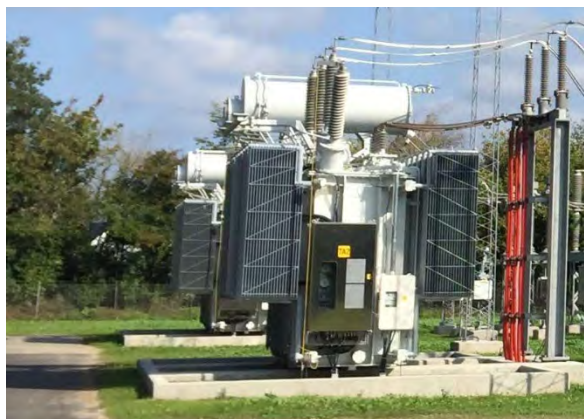
Figur 2-6 Eksempel på 150 kV transformatorstation tv og lynafledningsmaster th.
