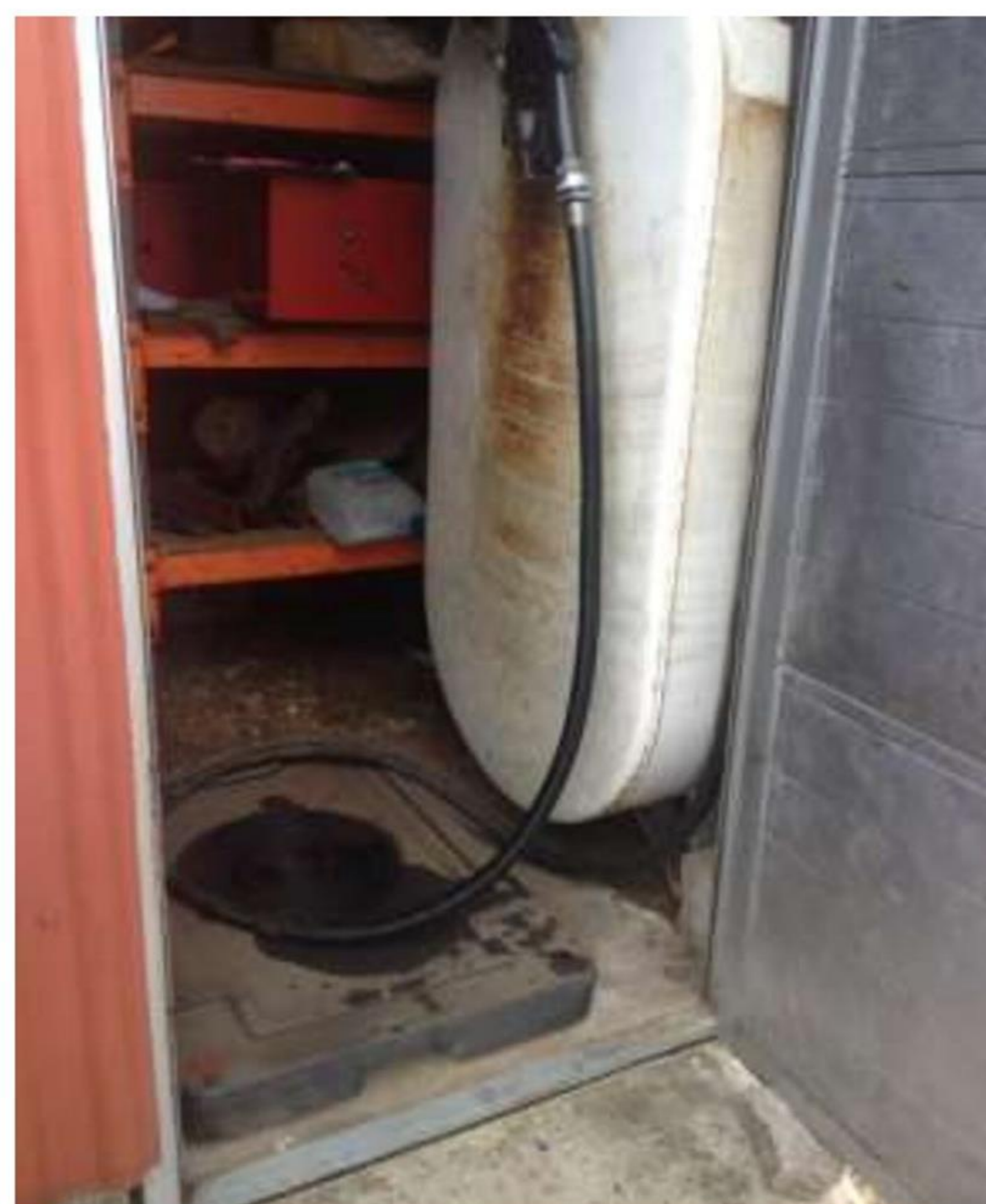
Fint eksempel på spildebakke under tankstuds.
