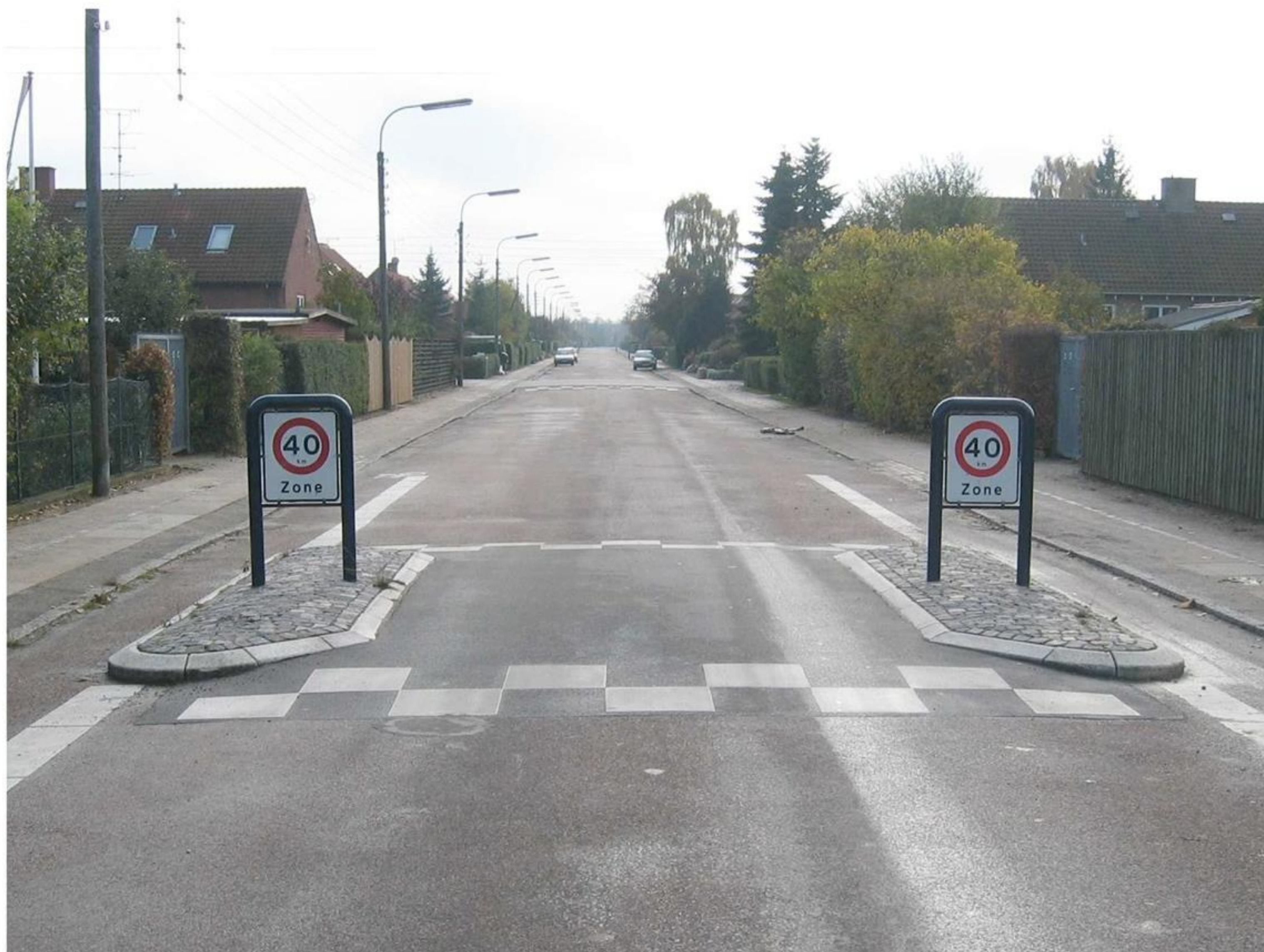
Figur 7 Eksempel på indkørsel til hastighedszone med E68.4-tavler.
