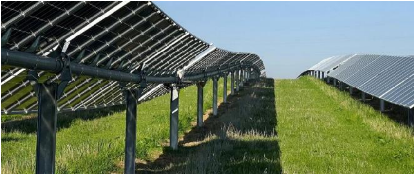
Figur 11. Billede af eksempel på solcellepaneler på trackersystem, som flytter solcellepanelerne i takt med solens bevægelse fra øst mod vest.
