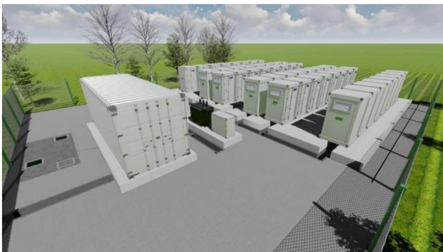
Figur 14. Eksempel på BESS anlæg på 20 MWh. Kilde GreenGo Energy
