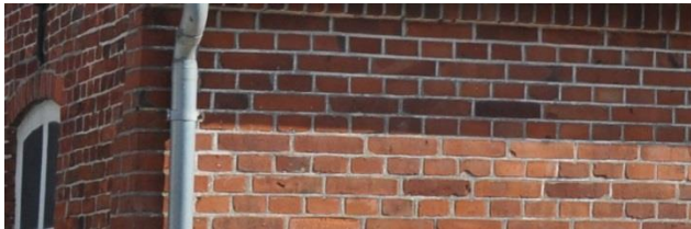
Krydsforbandt, med opstregede fuger. Herbergsgade 3.
