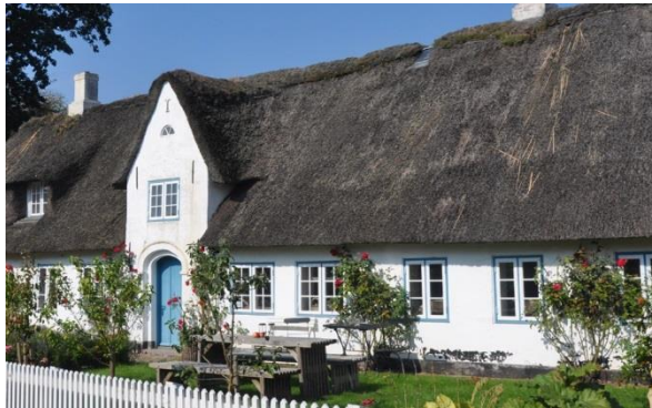
Kalkede overflader skal med den rette gode kalk genbehandles ca. hver 5-8 år. Kalken giver en stofflig overflade der spiller sammen med husets materialitet. Møllegade 4.
