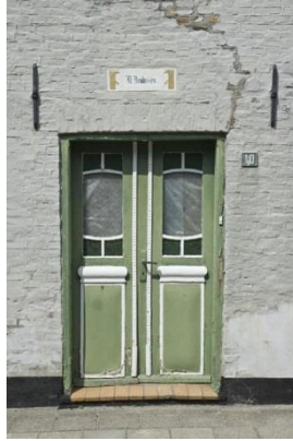
Postgade 10, 1875. Fløjdør med empire-træk. Fyldningsdør med glas i øvre del og nyere fyldning i nedre. Adskilt af s-profil. Slaglisterne er dekoreret med tandsnit.
