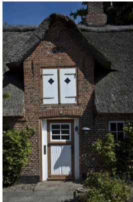
Kovej 3, 1877 Enkelt dør med seksdel- rude og nedre felt med postament udtryk. Formodentligt nyere dør der har erstattet dobbelt fløjdør, da dørhullet er meget bredt.
