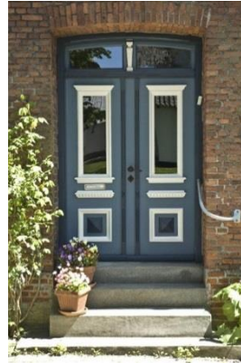
Herbergsgade 9, 1894. Enkelt dør med overvindue med centralt placeret søjlemotiv. Bred dobbelt fløjdør med pilasterligende træk med højt smalt vindue, tværmidterstykke med tandsnit og kvadratisk bosset nedre fyldning
