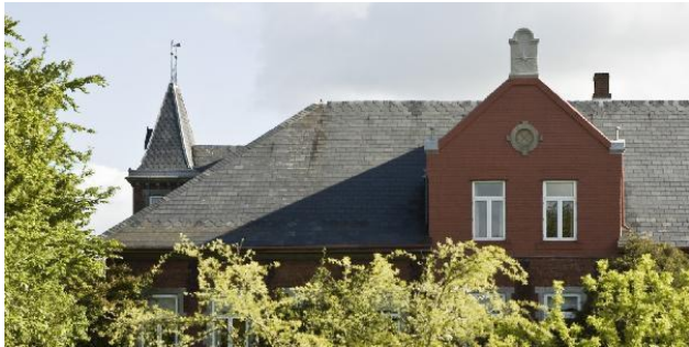
Tøndervej 1, 1875. Skifer er brugt på tagfladen samt på tårnet Bemærk den tungede skifer der virker som dekorativt element på tagfladen lang rygningen mv.
