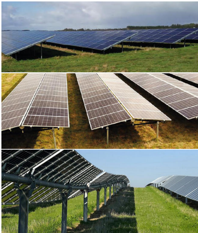
Figur 9. Tre billeder med forskellige opsætning af solcellepaneler. Øverst ses stationære solcellepaneler vinklet mod syd, i midten ses solcellepaneler i sad-deltag udformning. Nederst ses solcellepaneler på trackersystem, som flytter solcellepanelerne i takt med solens bevægelse fra øst mod vest.
