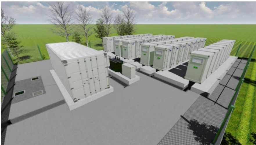
Figur 12. Eksempel på BESS anlæg på 20 MWh. Kilde GreenGo Energy
