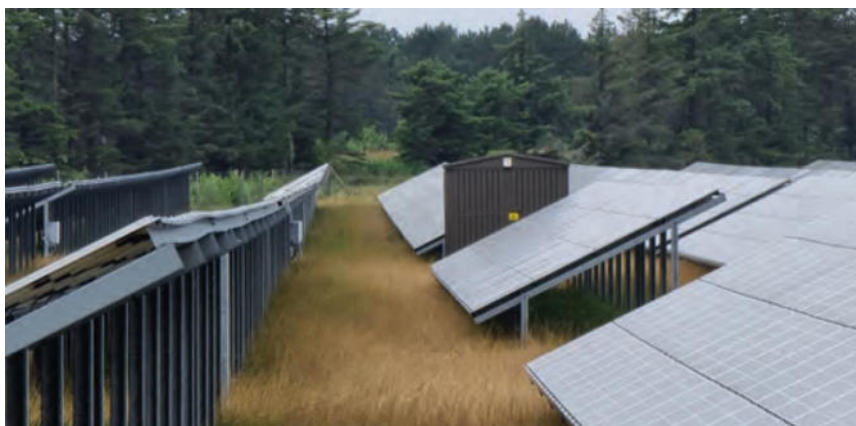
Figur 10. Billede af eksempel på en fordelingstransformer.
