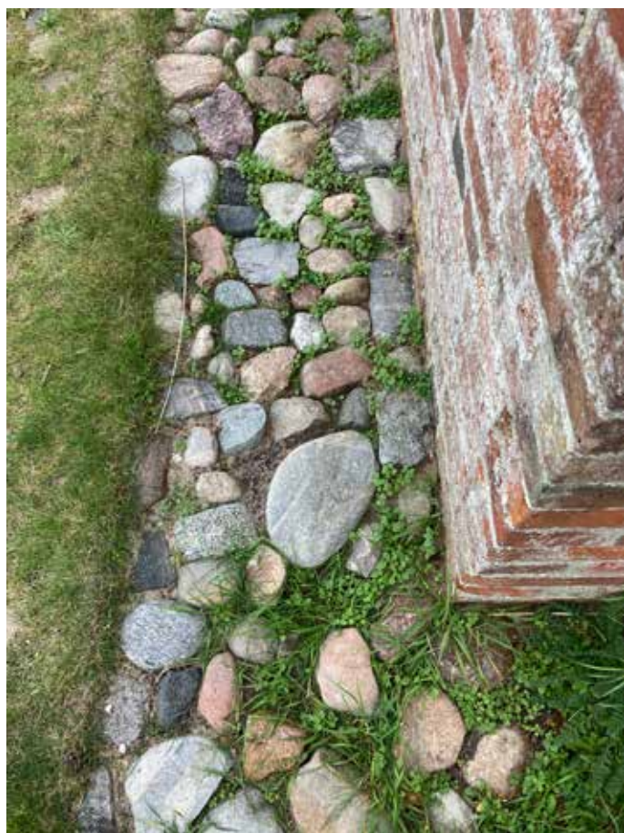
Pigstens belægning langs ydermuren, Kommandørgården Foto: Tegnestuen Stedse
