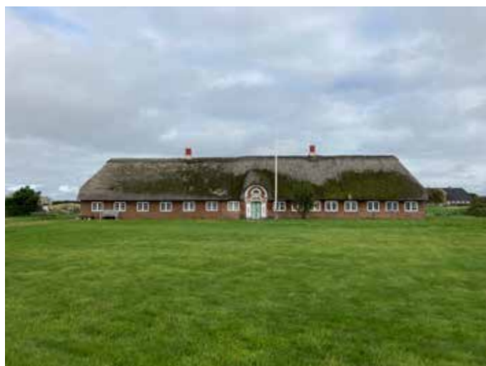
Billedet er fra oktober 2020. Den gamle stalddel mod vest er nedrevet og erstattet med en udvidelse af beboelseshuset, som et længehus (husets venstre side). En ombygning som denne vil kunne accepteres, da staldlængen (vist på billedet øverst på siden) er en nyere tilføjelse fra 1930'erne og ikke harmonerer med hovedhusets arkitektoniske udtryk. Foto: Tegnestuen Stedse
