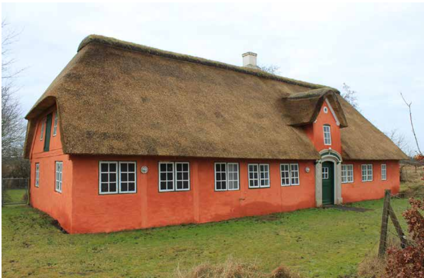
Tilmurede vinduer påmales i tråd med den oprindelige byggeskik, så facadens rytme og harmoni bevares. Foto: Tegnestuen Stedse
