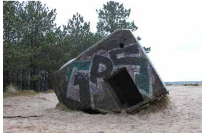
Bunkers i Tvismark Plantage Foto: Tegnestu Stedse
