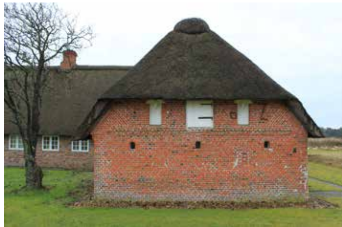
Nordgavl med glughuller og lem til loft, Foto: Tegnestuen Stedse
