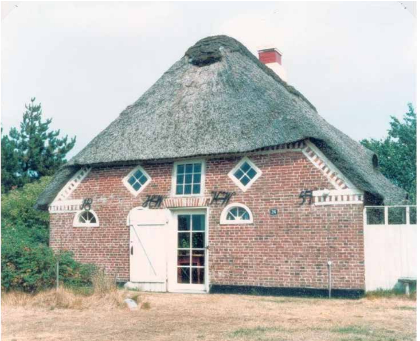
Der er isat en glassdør bag den bevarede revledør. I loftslommen er isat et sprosset glasfelt, der passer til husets arkitektoniske udtryk. Foto: Aksel Skov
