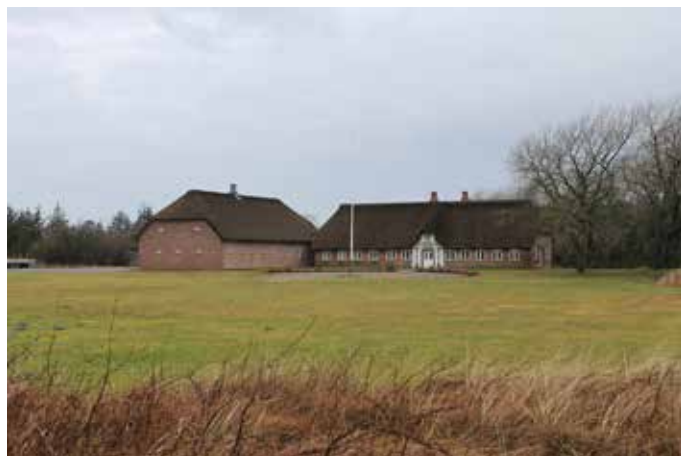
Nyere staldbygning udført i materialer og stil, som harmonerer med det oprindelige hovedhus. Den nyere opførte bygning er placeret, som en selvstændig sydgående længe vinkelret på husets vestlige gavl. Taget er dog ikke sammenhængende med hovedhuset. Foto: Tegnestuen Stedse
