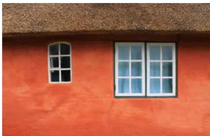
Facadeudsnit, den udvendige ramme er med enkelt lag plant glas fastholdt i kitfals. Staldvinduet er med støbejernsramme. Foto: Tegnstuen Stedse
