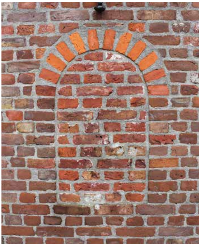
Et tilmuret staldvindue. Vinduet markeres i facaden med svag nuanceforskkel i stenene. Foto: Tegnestuen Stedse
