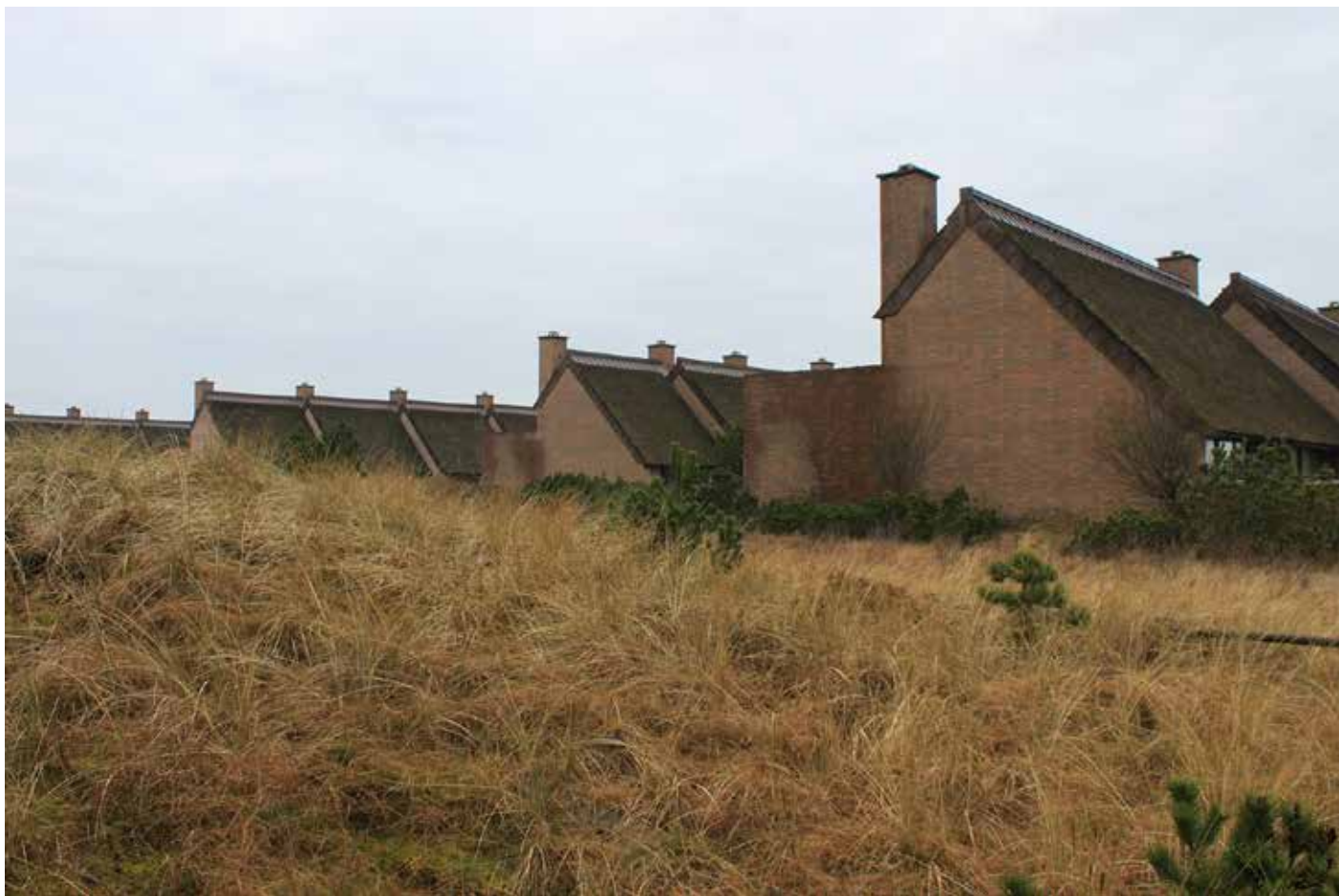
De rødbrune tegl og stråtagets brune nuancer skaber en tydelig reference til den oprindelige byggeskik. Materialerne patinerer smukt over tid og farverne indpasser sig naturligt i områdets egnstypiske vegetation.
