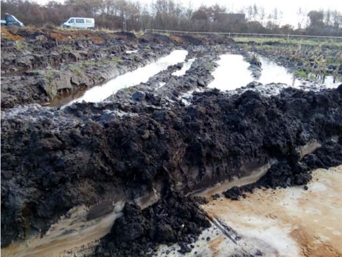
Fig. 1: Store mængder overfladevand sivede i søgegrøfterne straks efter muldafrømning hvilket gjorde det vandskellig at snitte og registrere anlæg.
