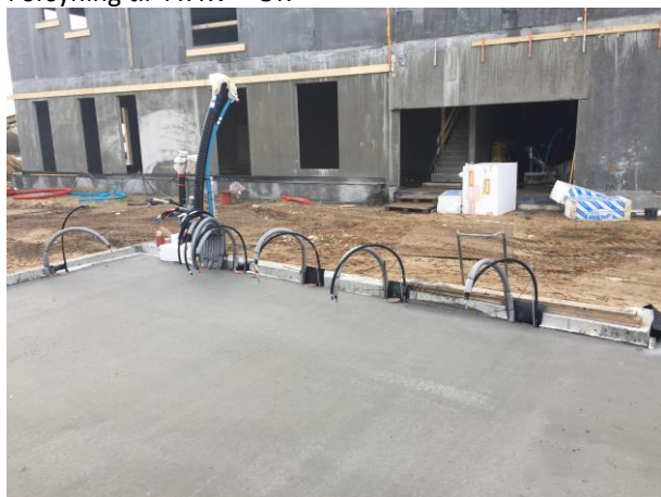
Afsætning og fastgørelse af forsyningsrør – OK
