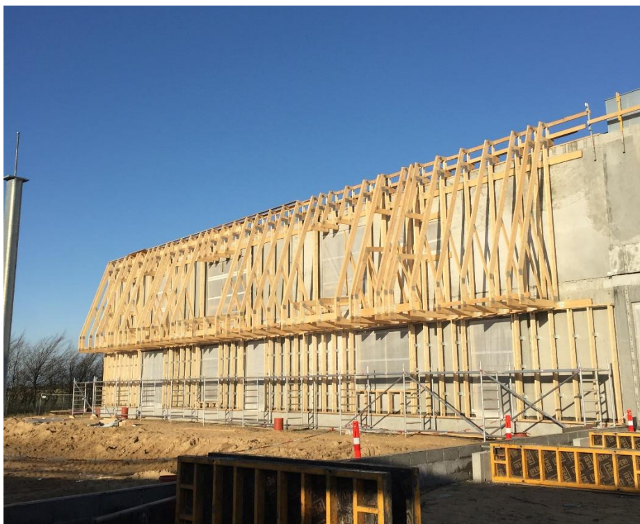
Byggepladsen på tilsynstidspunkt
