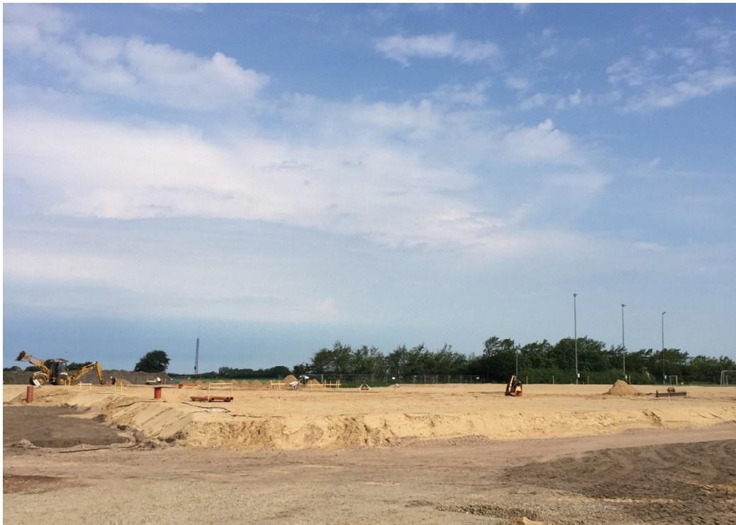
Byggepladsen på tilsynstidspunkt
