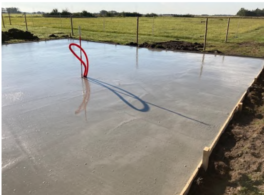
Foto af det etableret betonplade.
