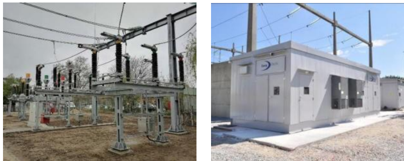
Figur 8. Referencebilleder med et fritstående til venstre og et kompakt system til højre til samling af nettilslutning.
