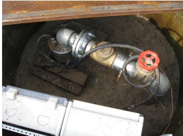
Foto indefra: Boring i overbygning
