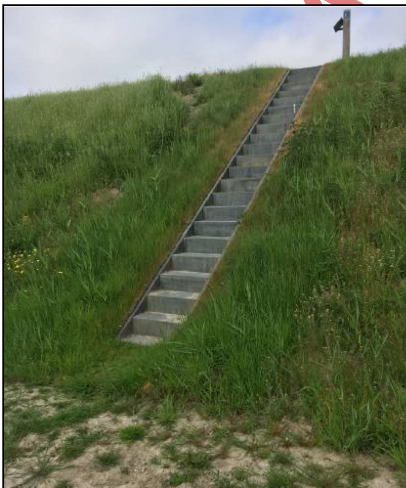
Foto der viser eksempel på trappe
