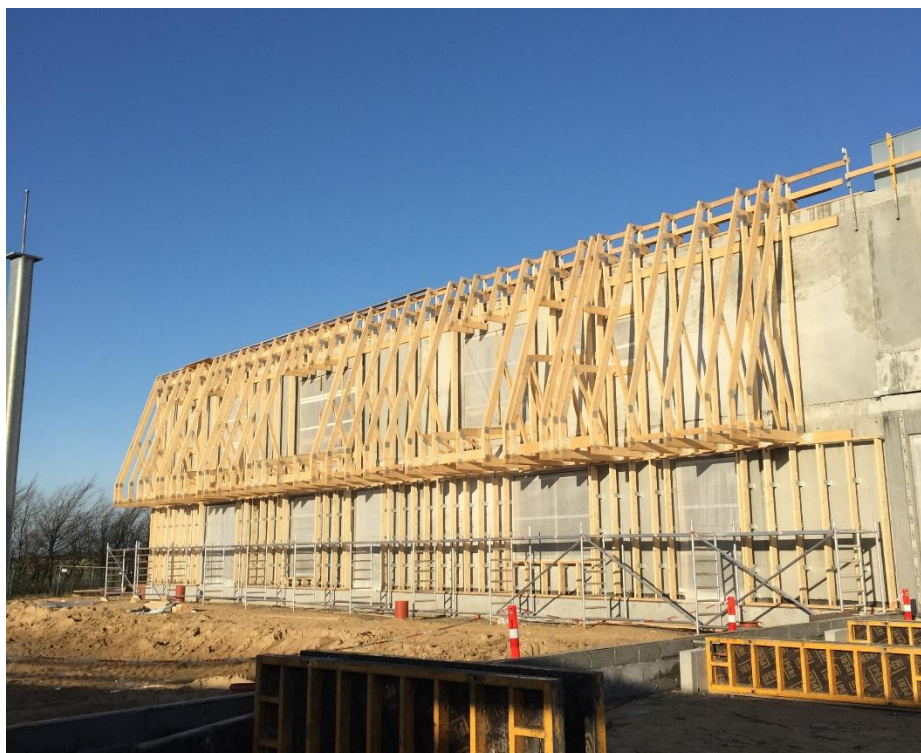
Byggepladsen på tilsynstidspunkt
