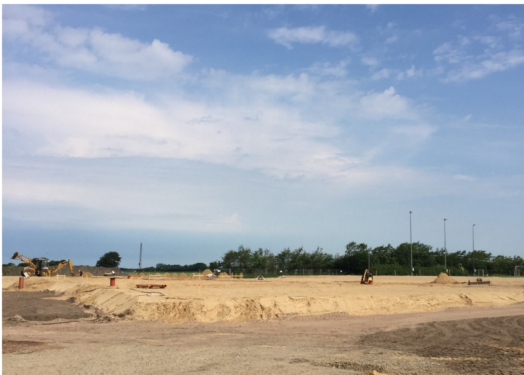
Byggepladsen på tilsynstidspunkt
