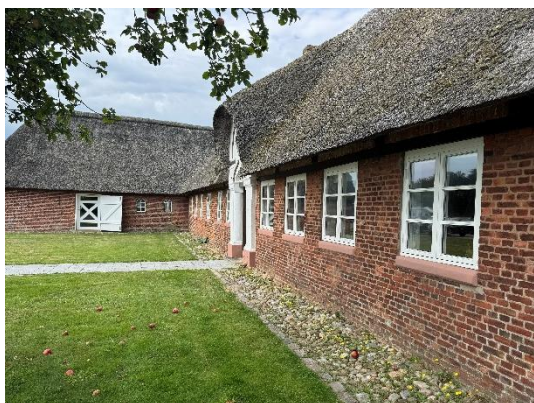
Vinduerne sidder rytmisk. For foden af bygningen ligger pigsten.
