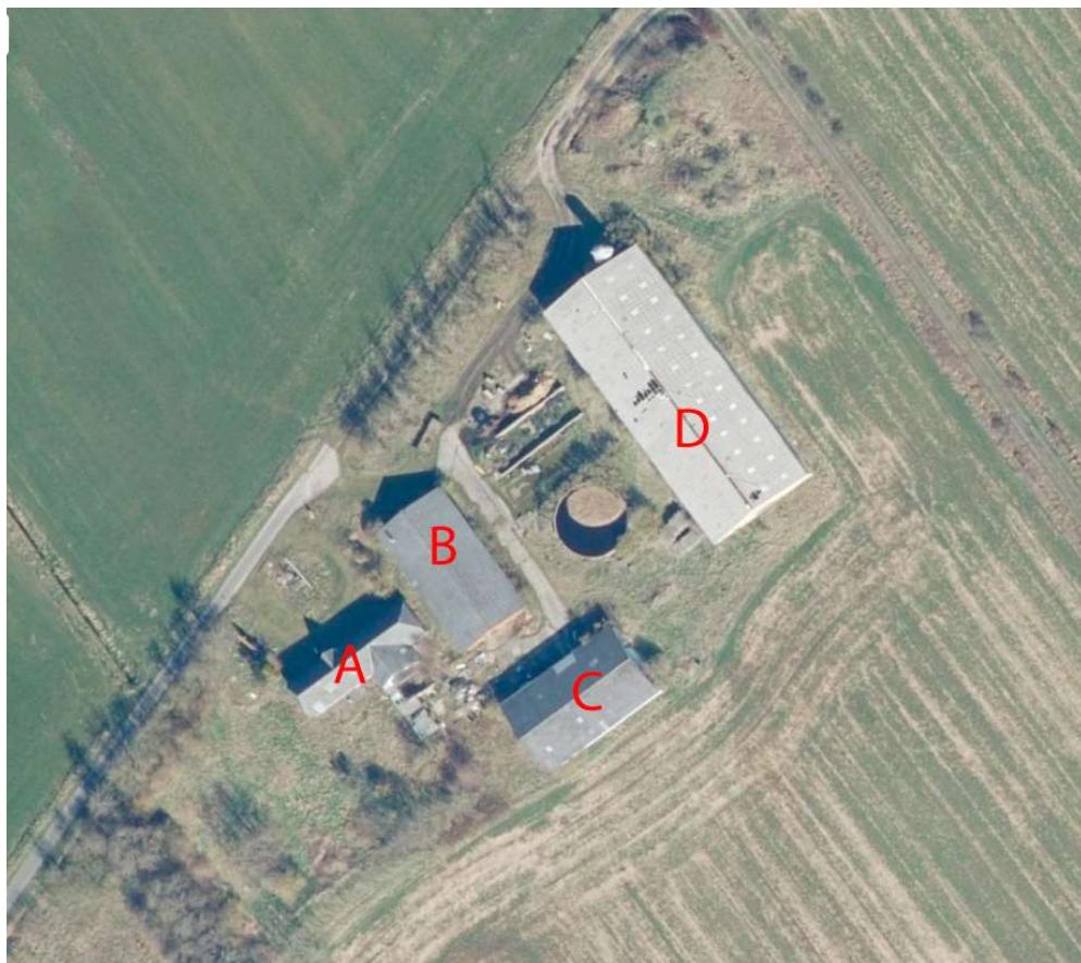
Figur 1. Bygningerne på adressen Ballum Hede 5.
