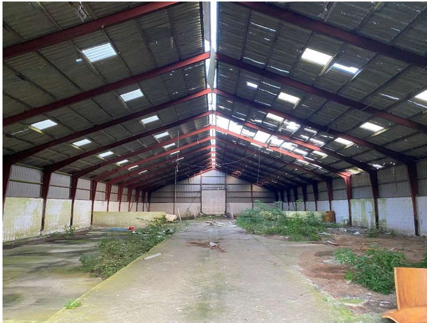
Figur 8. Bygning D set indefra.
