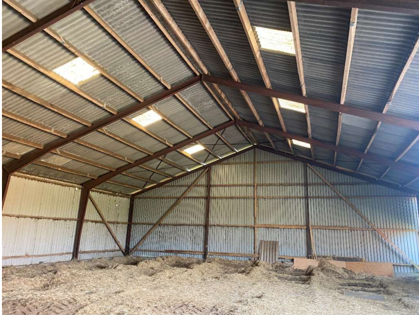
Figur 7. Bygning C set indefra.
