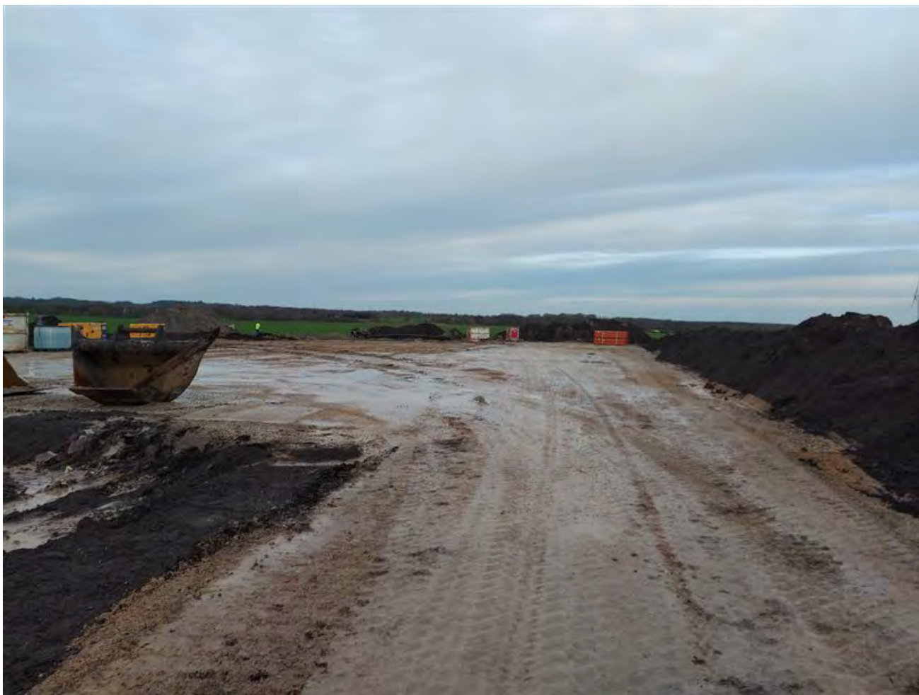
Figur 5.5.1 Fotoeksempel på etablering af adgangsvej med stabilgrus og kranplads omkring en kommende vindmølle.
