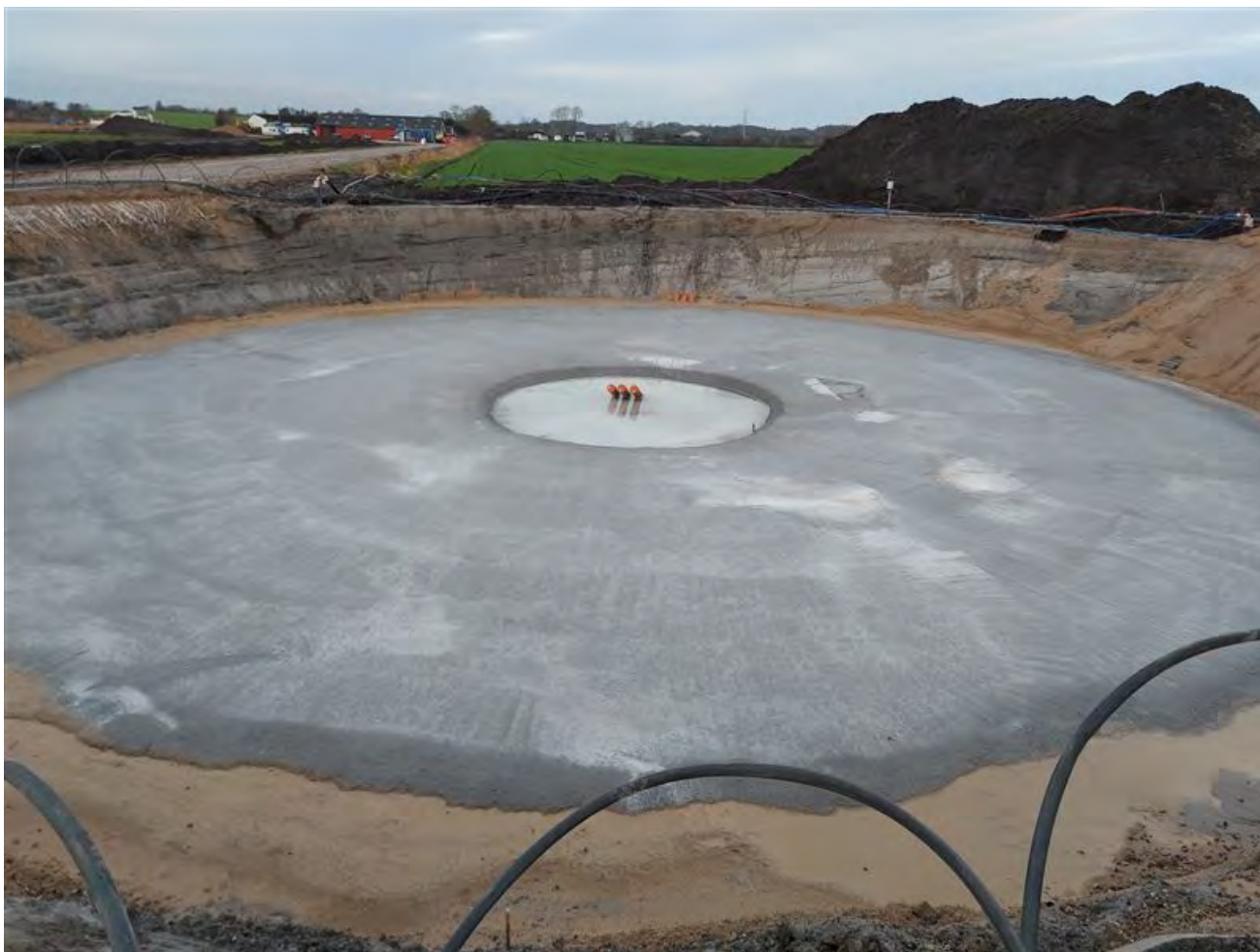
Figur 5.5.2 Fotoeksempel på pladefundament til en Vestas vindmølle.
