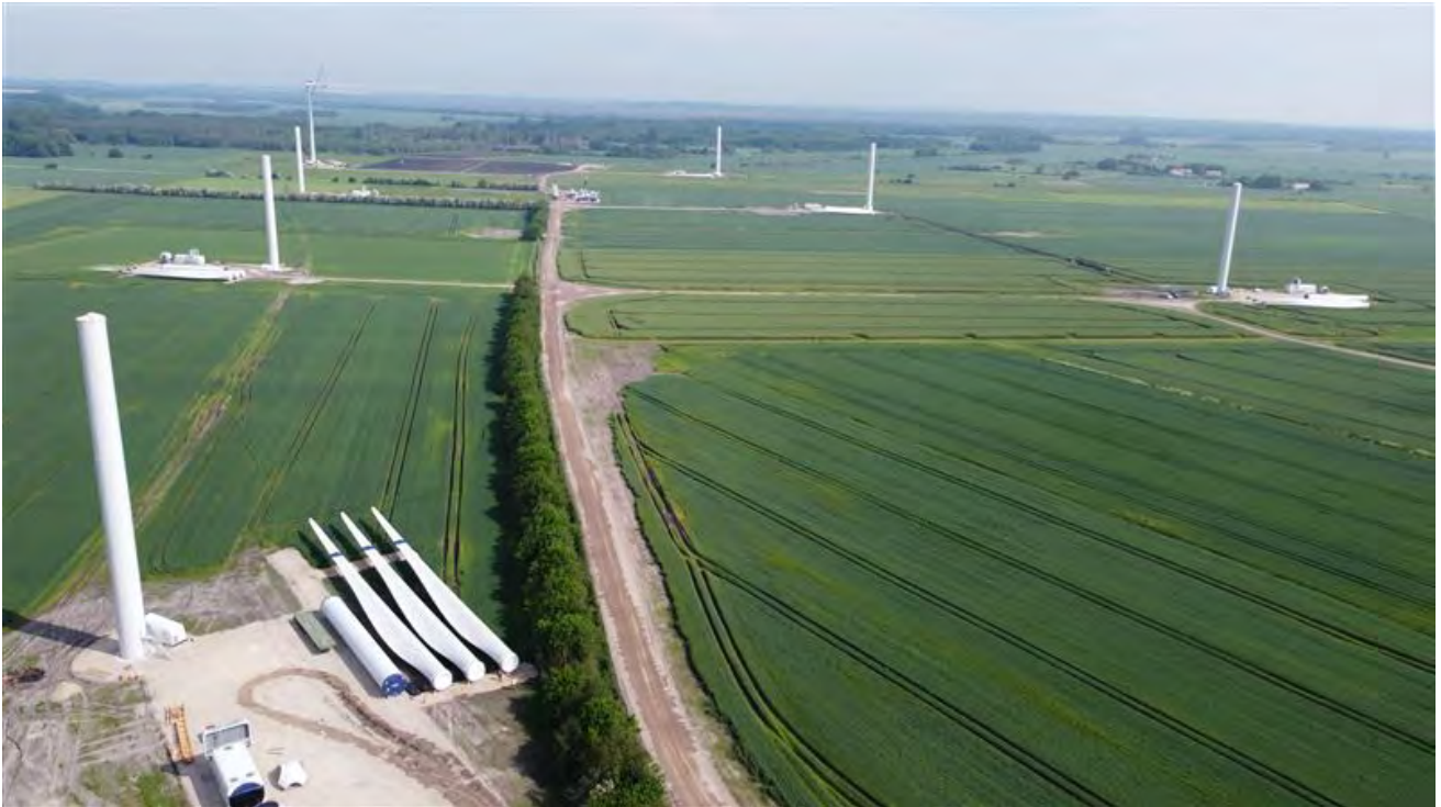
Figur 5.5.3 Eksempel på anlægsarbejde ved opstilling af Vestas vindmøller.
