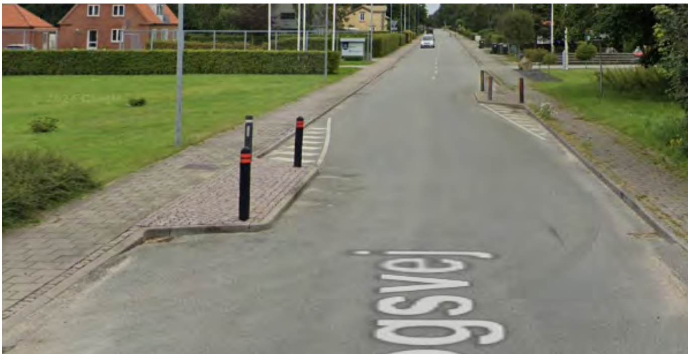
Figur 7.11.3 Side heller på Kogsvej, set fra krydset med Rejsby Landevej mod øst (Google Maps, 2024).
