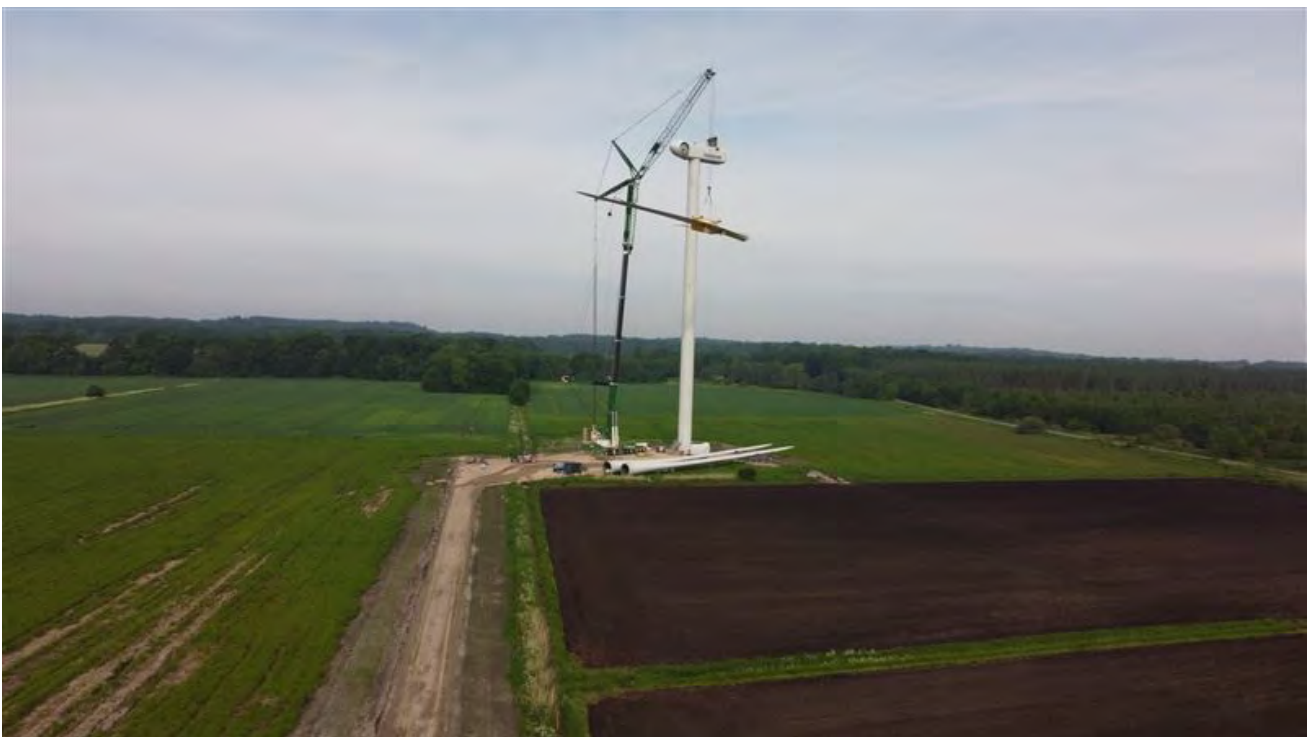
Figur 5.5.4 Arbejdsplads med kran under løft af vinge til en Vestas vindmølle.
