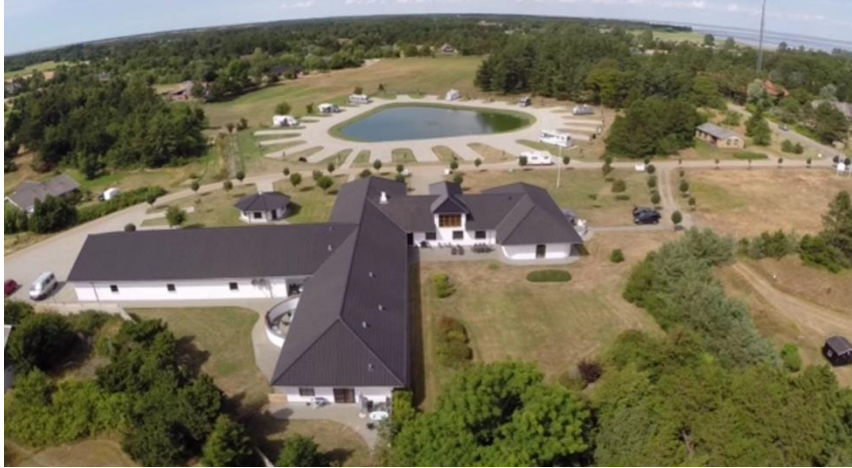
Billede 3: Delområde D1, i forgrunden, med bygningsparcel, og delområde D2, i baggrunden, med den "lille plads". Billedet er fra http://oasens-roemoe.dk/
