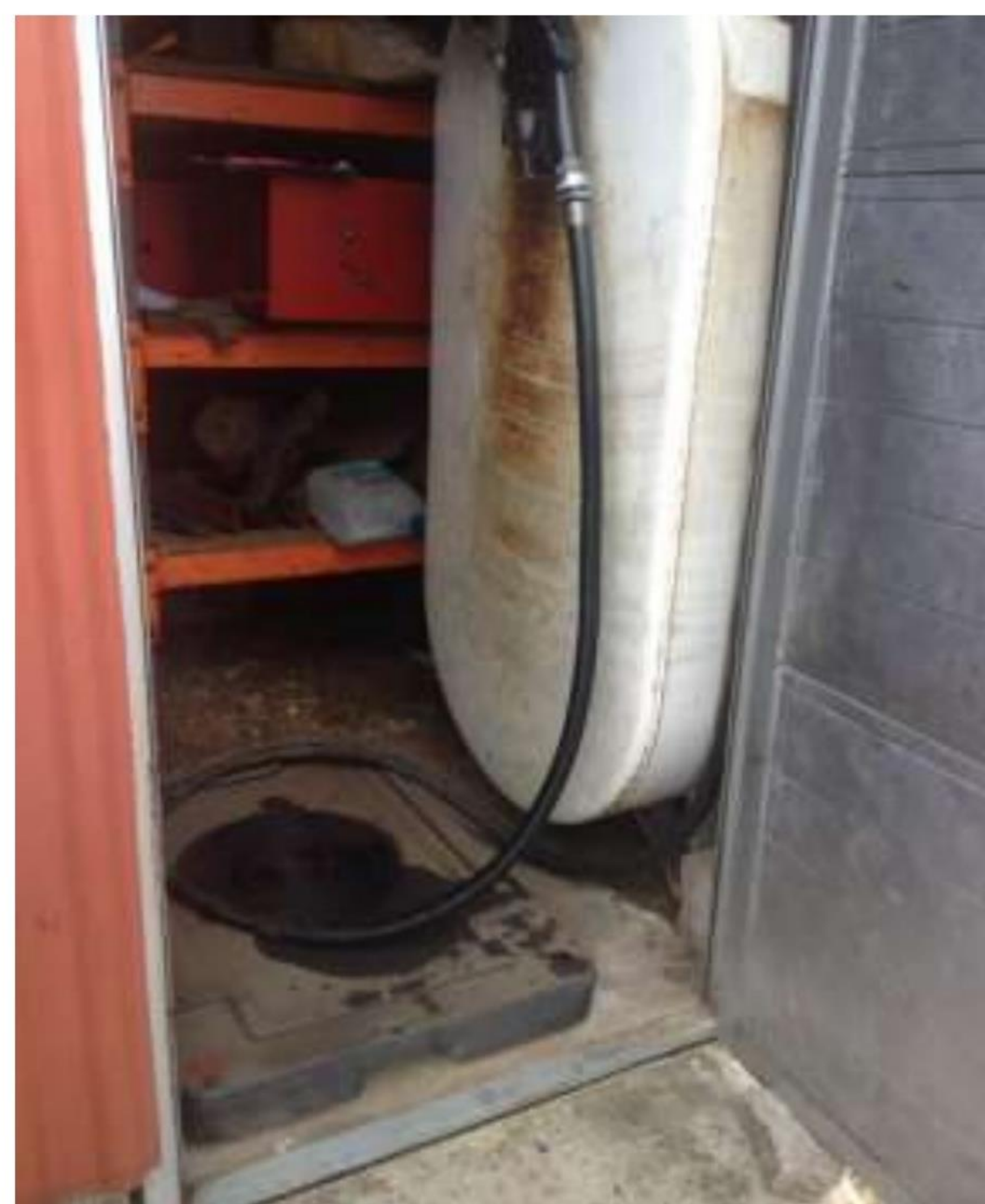
Fint eksempel på spilbakke under tankstuds.
