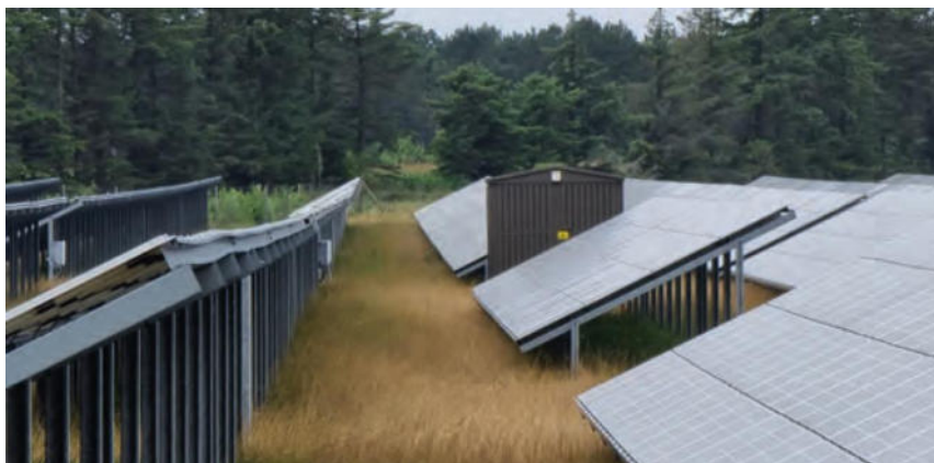
Figur 12. Billede af et eksempel på en fordelingstransformer.
