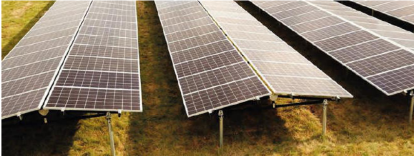
Figur 10. Billede af eksempel på solcellepaneler i saddeltag udformning.
