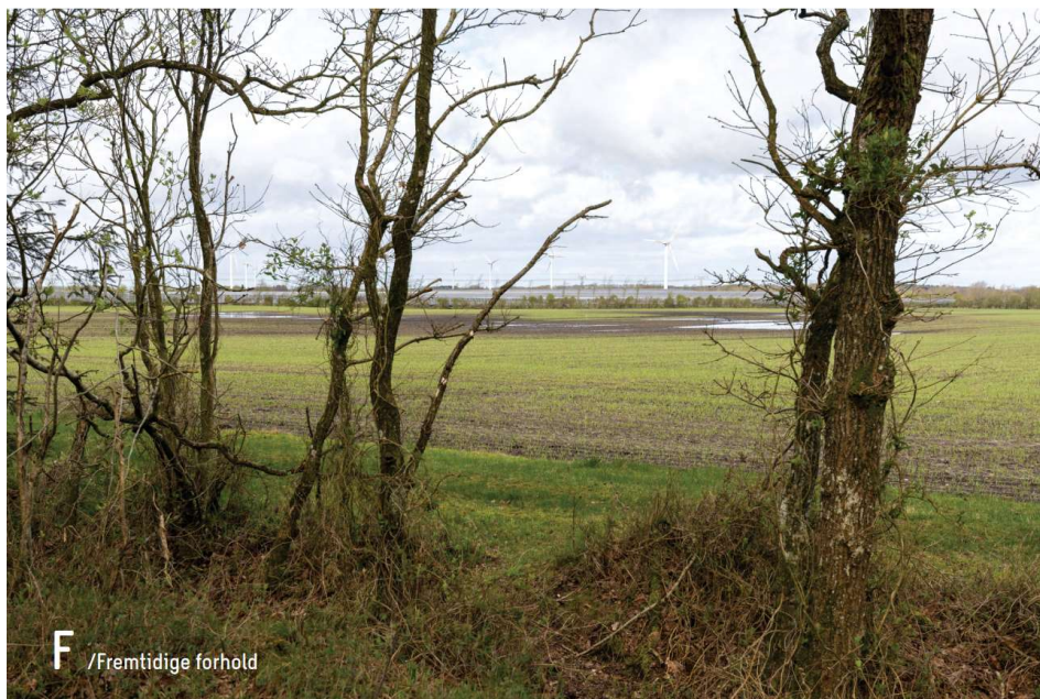
Figur 14-19 Fotostandpunkt F - tracker-anlæg
