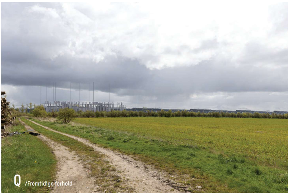
Figur 14-47 Fotostandpunkt Q - tracker-anlæg med step up-transformerstation.
