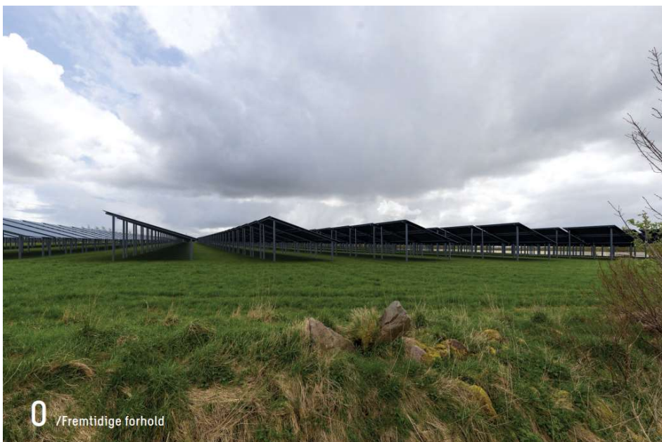
Figur 14-42 Fotostandpunkt O – fastmonteret anlæg
