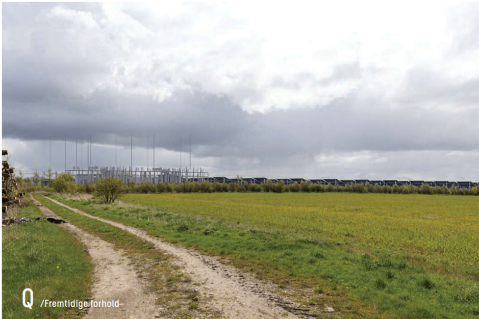
Figur 14-46 Fotostandpunkt Q - fastmonteret solcelleanlæg med step up-transformerstation.
