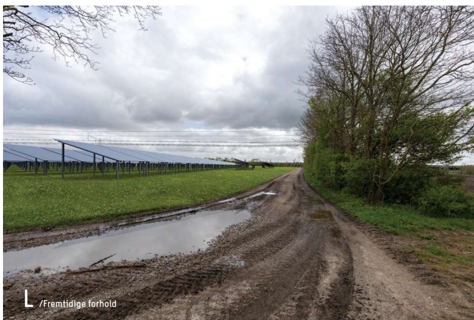
Figur 14-34 Fotostandpunkt L med fastmonteret solcelleanlæg og den kommende højspændingsledning
