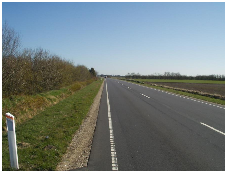
Figur 7: Eksempel på gennemfartsvej i åbent land.
