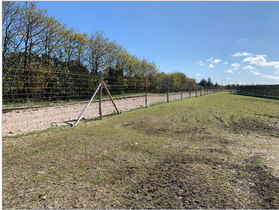
Billede 2: Eksempel på trådhegn rundt om en solcellepark.
